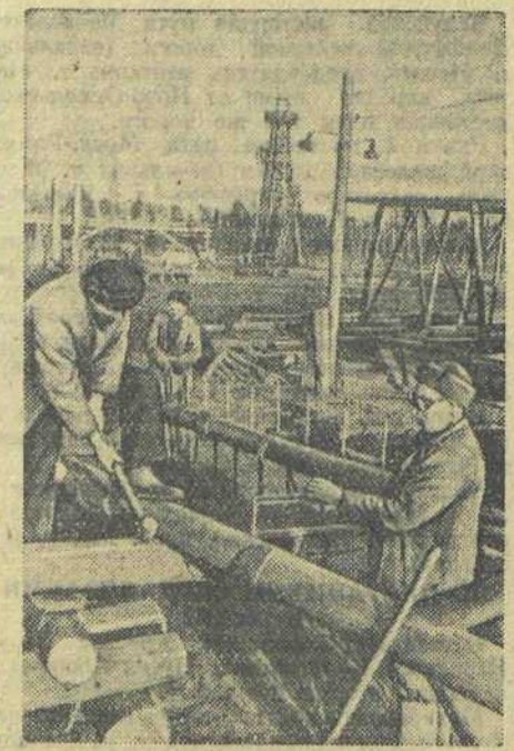
На нефтяных промыслах треста «Краснокамнефть» непрерывно ведется в эксплуатацию новые бурные скважины, увеличивающие добычу нефти. На снимке стахановская строительно-монтажная бригада Н. С. Комариных собирает основание для новой буровой. Фото А. Фатеева.
